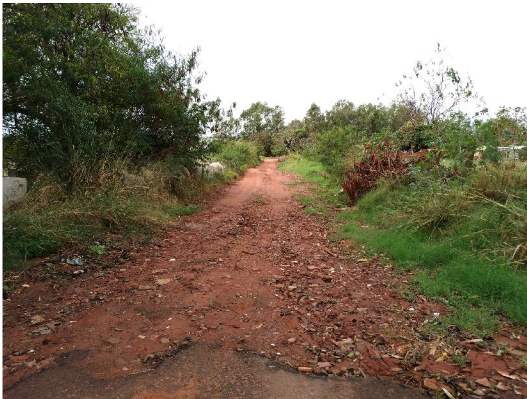
Figura 6- INÍCIO DO TRECHO 3 DA RUA HÉLIO BARCO
