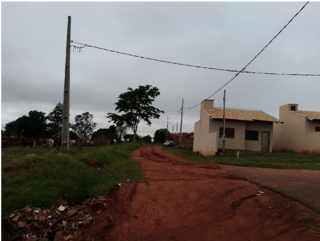
Figura 1- INÍCIO DO TRECHO 1 DA RUA HÉLIO BARCO
